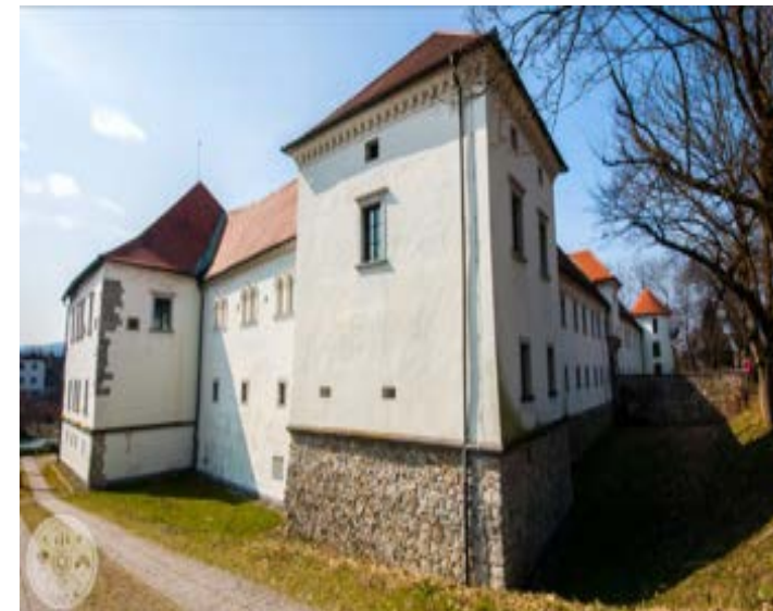
Pogled na graščino z vzhodne smeri - značilna dvojna okna-bifore; edini fasadni okras so značilni renesančni konzolni napuščni venci
