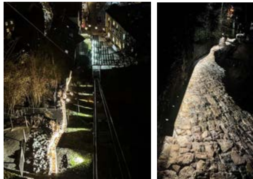
Ponoči osvetljen del obrambnega zidu na Grajskem hribu pod vzpenjačo na Grad; desno zgoraj Krekov trg
